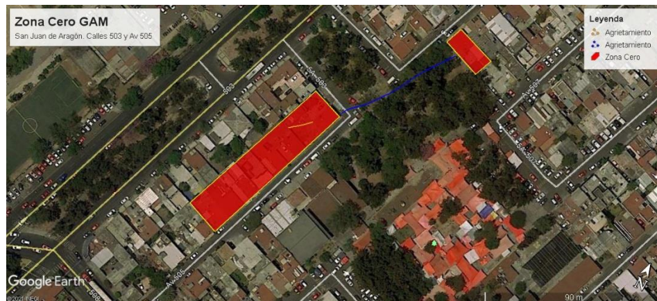
Figura 2. Zona crítica con afectaciones en viviendas por grietas registradas en la zona.
